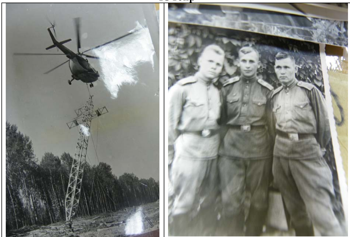
Установка опор ЛЭП вертолетом Ми-8 методом поворота Курсант Оренбургского летного училища Жирнов ИМ с одно- курсниками.
